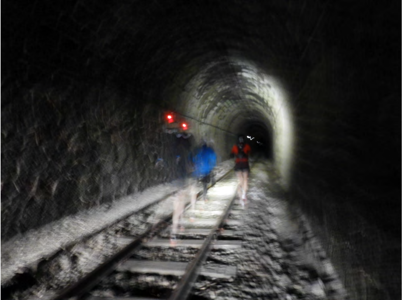
Entrada al famoso Túnel Mayor de 2.876 metros de longitud atravesando la Sierra de Alfabiá
